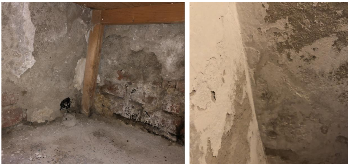
Obr. č. 5 – Vlhké obvodové steny na 1. P.P. v skladových priestoroch
