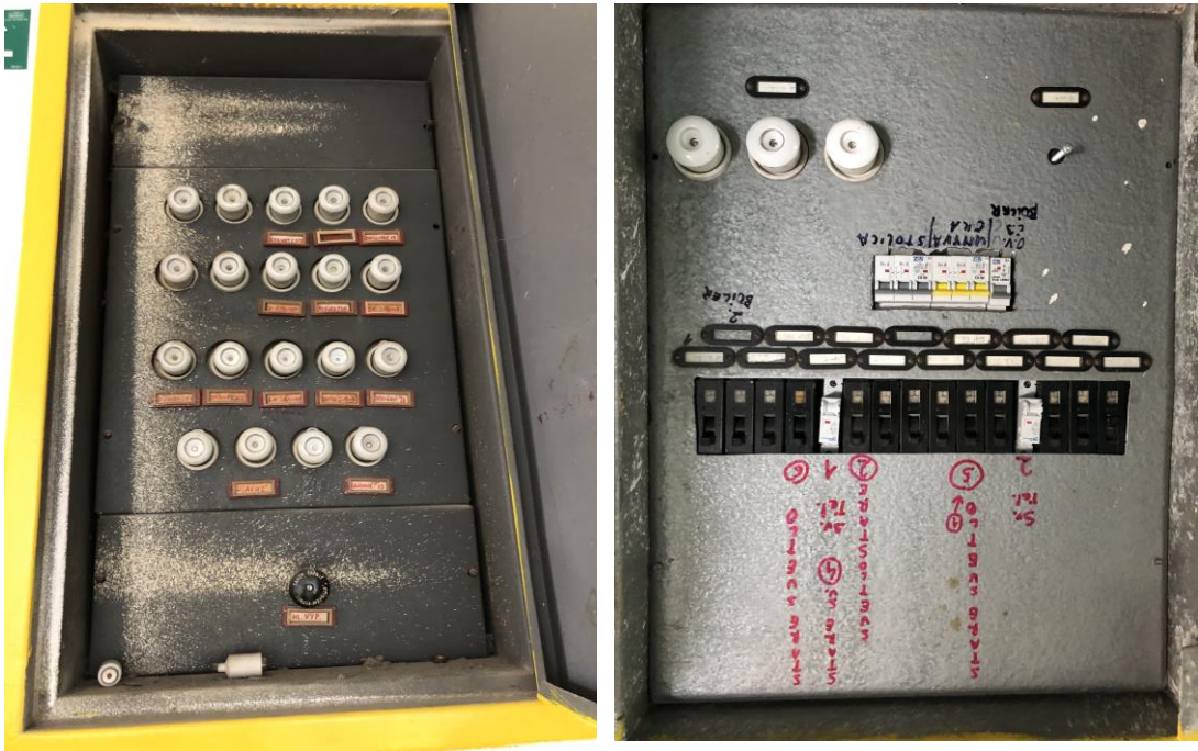
Obr. č.24 – Pôvodné rozvádzače v objekte školy
