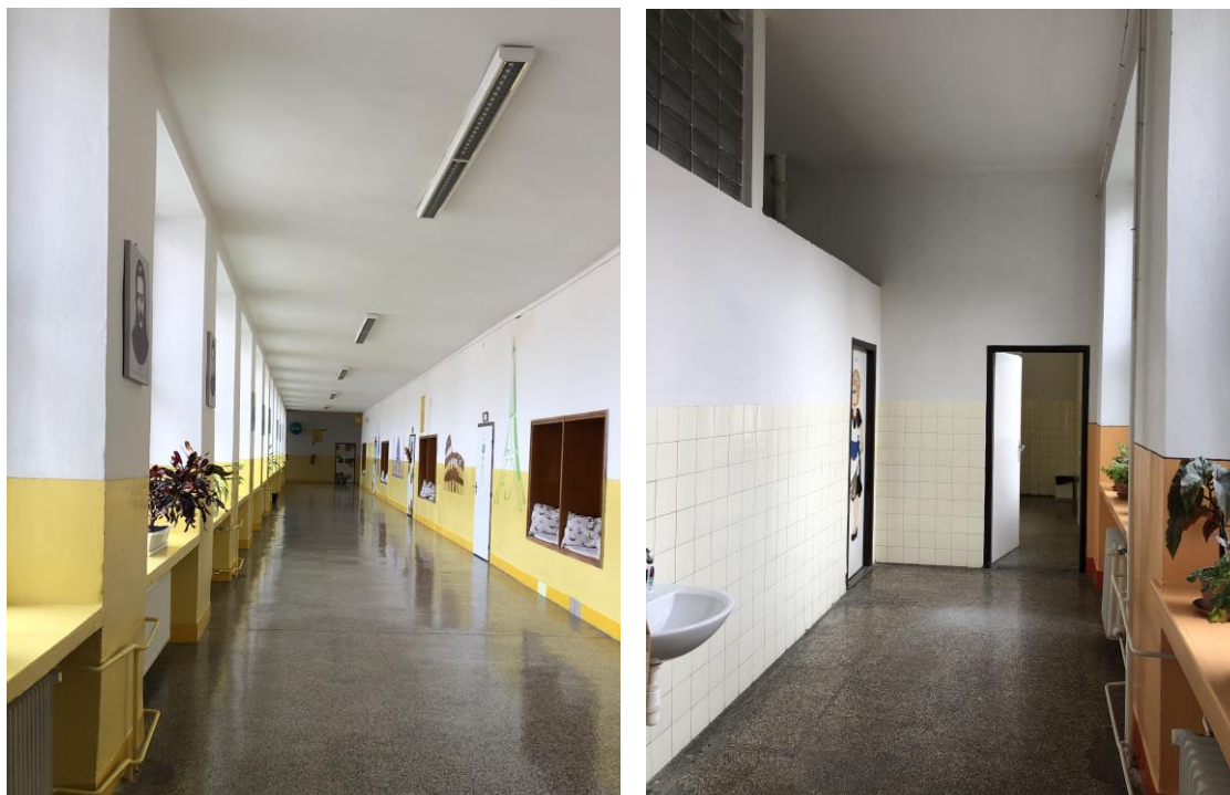
Obr. č. 11 – Steny na chodbe a keramický obklad na sociálnom zariadení
