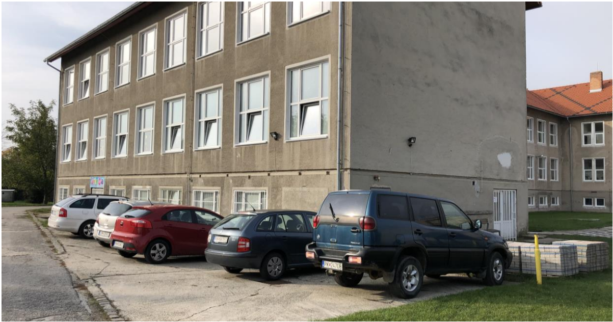
Obr. č.18 – Spevnené plochy využívané na parkovanie v areáli školy
