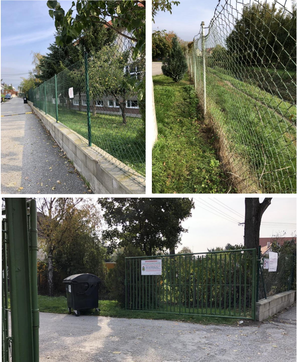
Obr. č.14 – Oplotenie areálu školy a vstupná brána
