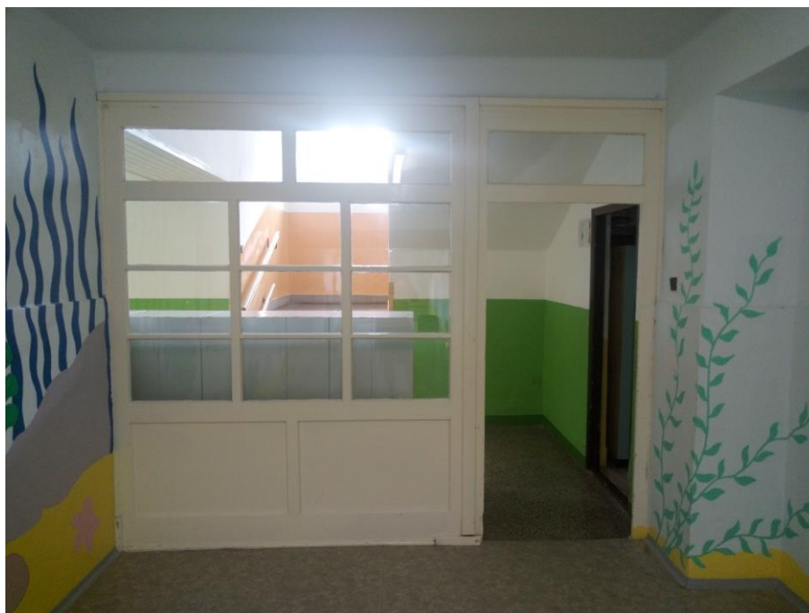
Obr. č. 7 – Vnútorne pôvodné presklenné drevené steny
