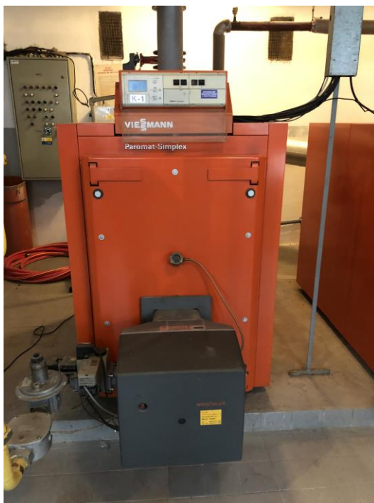
Obr. č.22 – Plynový kotol VISSMANN s výkonom 225 kW
