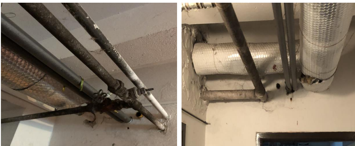
Obr. č.19 – Rozvod vody v pivničnom priestore
