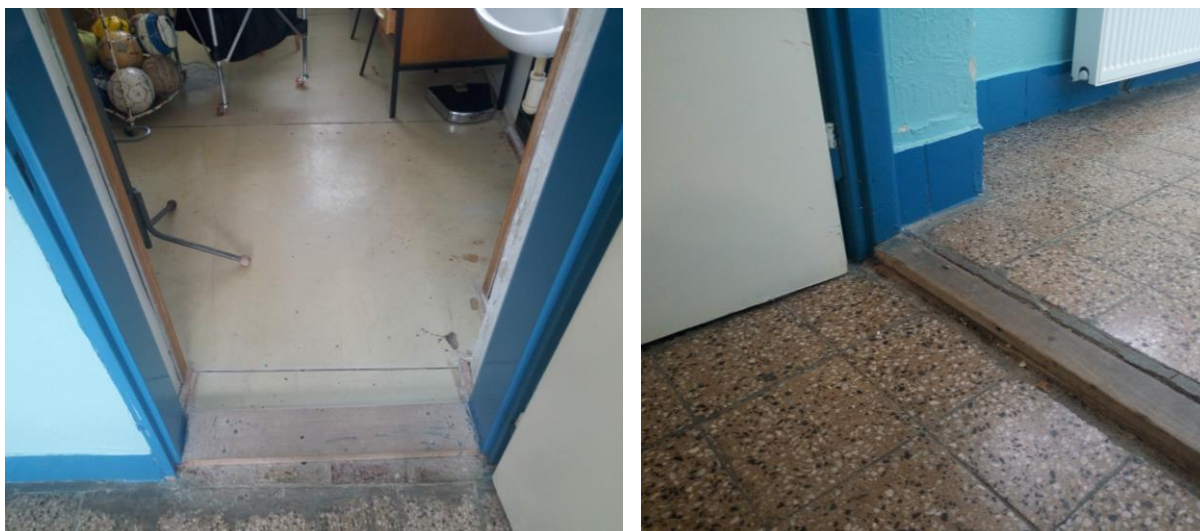
Obr. č.12 – Podlahy na chodbe a v kabinete telocvičňového traktu
