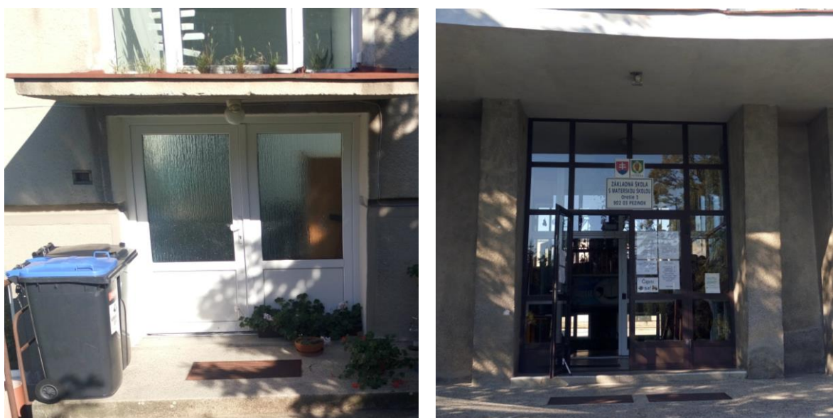
Obr. č. 9 – Vonkajšie dvere plastové a hlavné vstupné dvere oceľové
