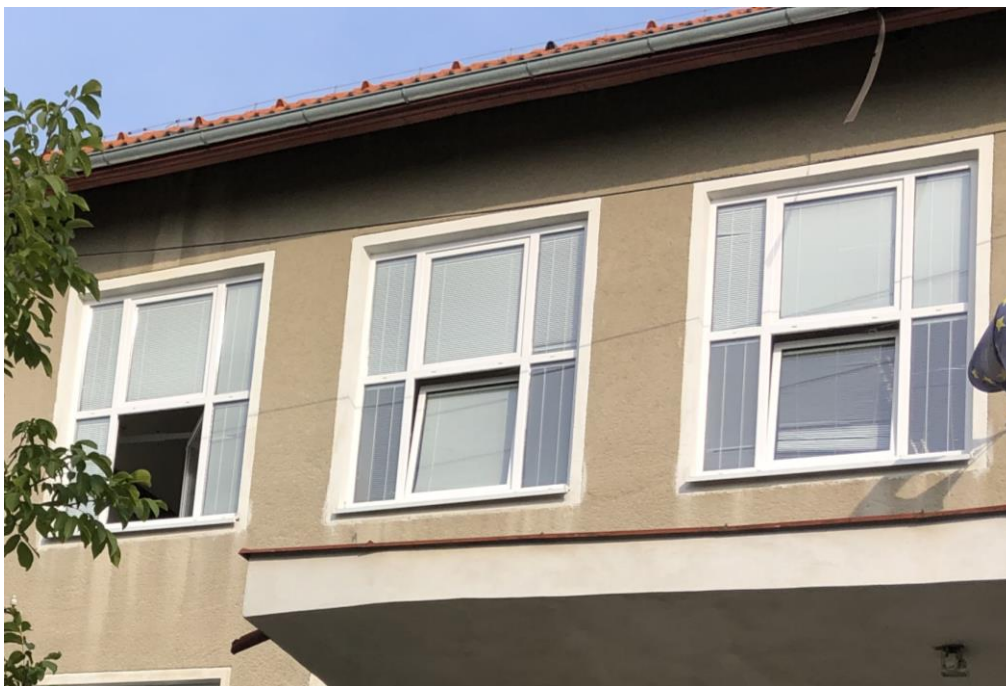
Obr. č. 6 - Vymenené otvorové konštrukcie – plastové okna s izolačným dvojsklom
