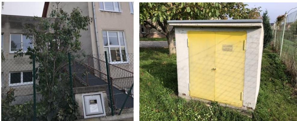
Obr. č.21 – Plynová skriňa pre služobné byty a plynová skriňa pre objekt ZŠ
