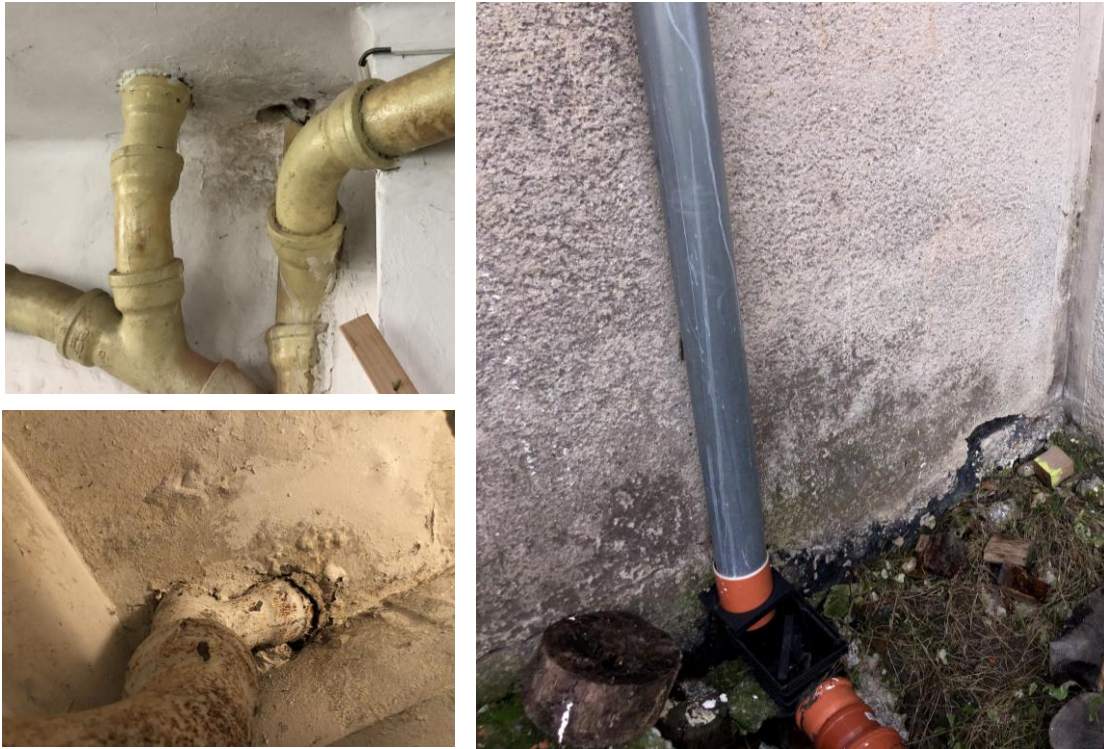
Obr. č.20 – Splašková kanalizácia v objekte a dažďové zvody
