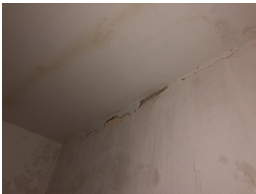
Obr. č. 4 – Trhliny pri styku priečnej a stropnej konštrukcie na 1.P.P. v časti telocvičňového bloku -
