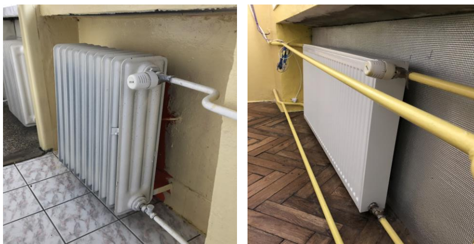
Obr. č.23 – Pôvodné radiátorové vykurovacie telesá a nové radiátorové telesá v priestoroch školy
