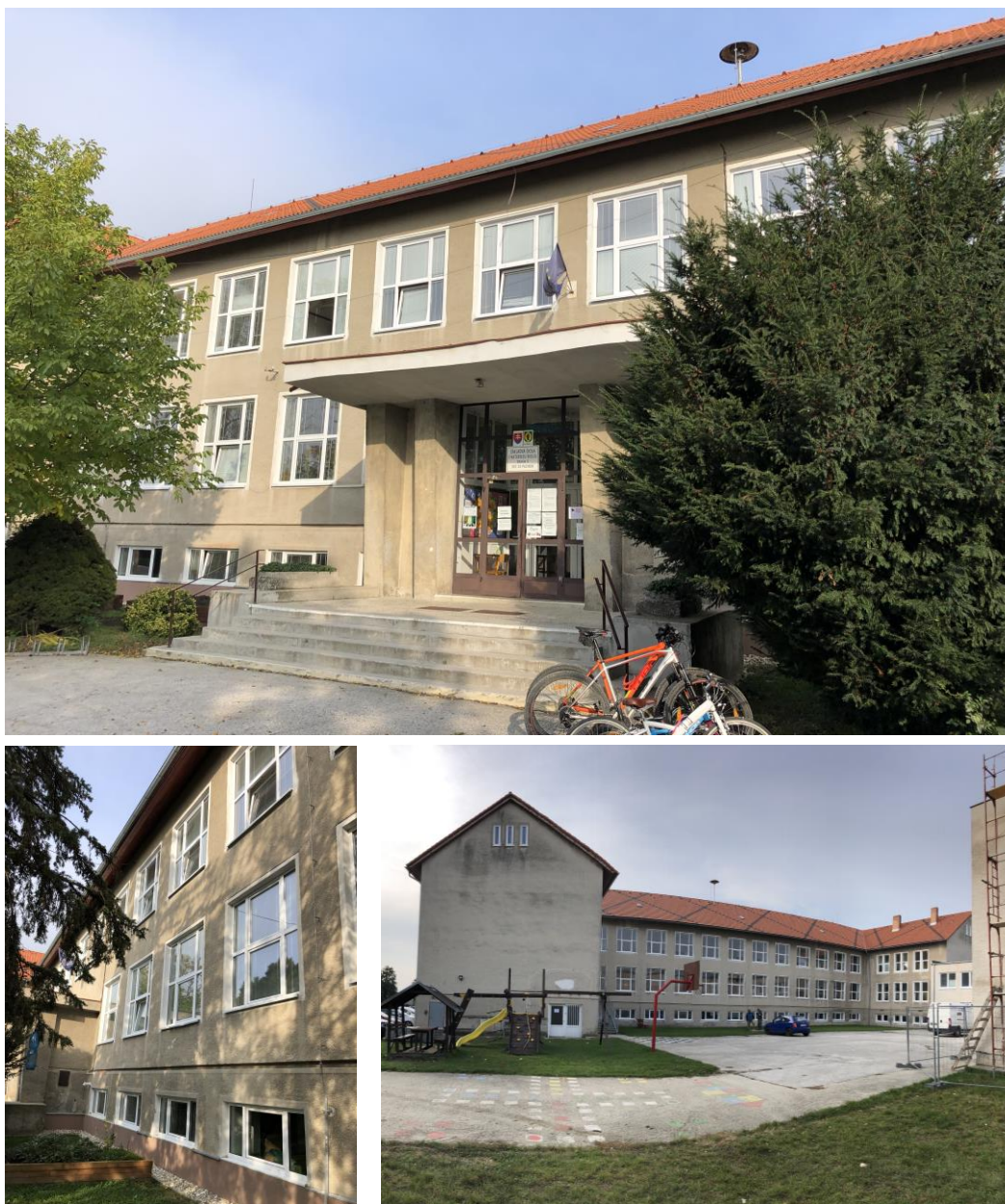
Obr. č. 3 – Pohľady na fasádu objektu
