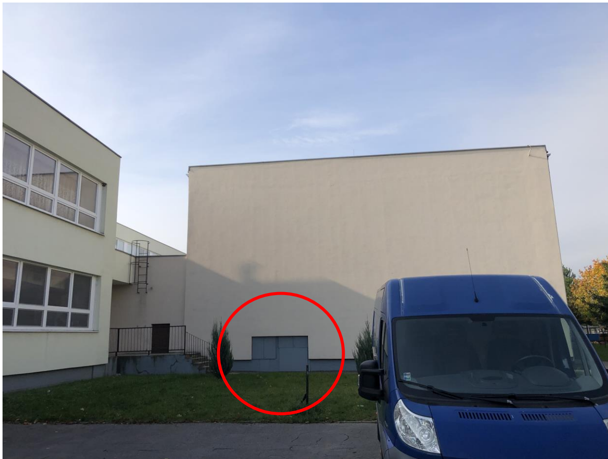
Obr. č. 18 Hlavný rozvádzač NN
