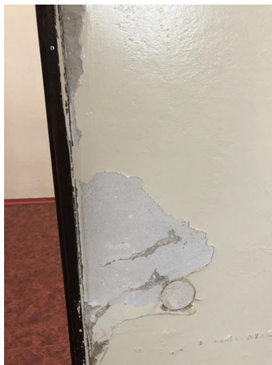
Obr. č. 4 Navlhnuté omietky v umyvárni a WC pri telocvični
