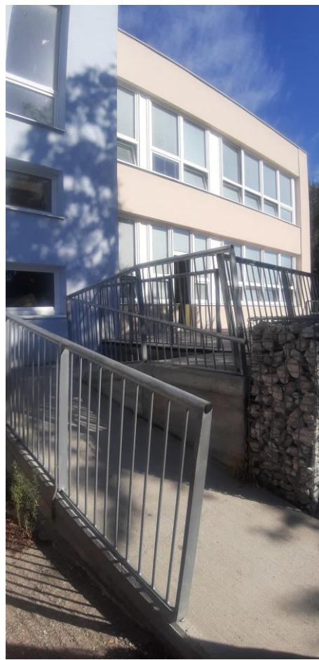
Obr. č. 2 Bezbariérový vstup do objektu školy
