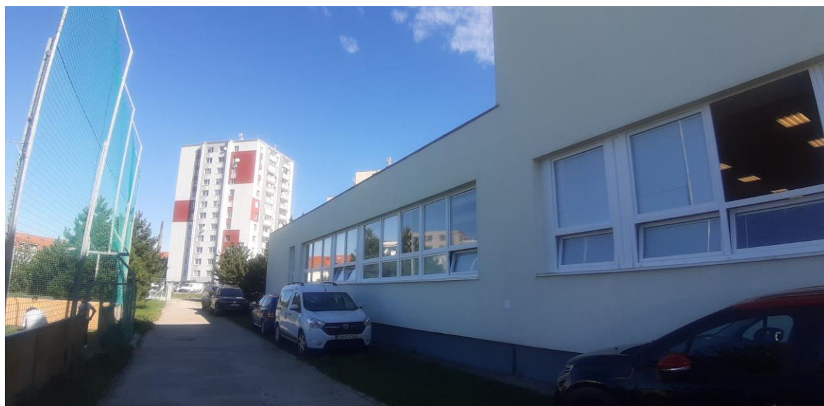
Obr. č. 5 Vymenené otvorové konštrukcie – plastové okna s izolačným dvojsklom
