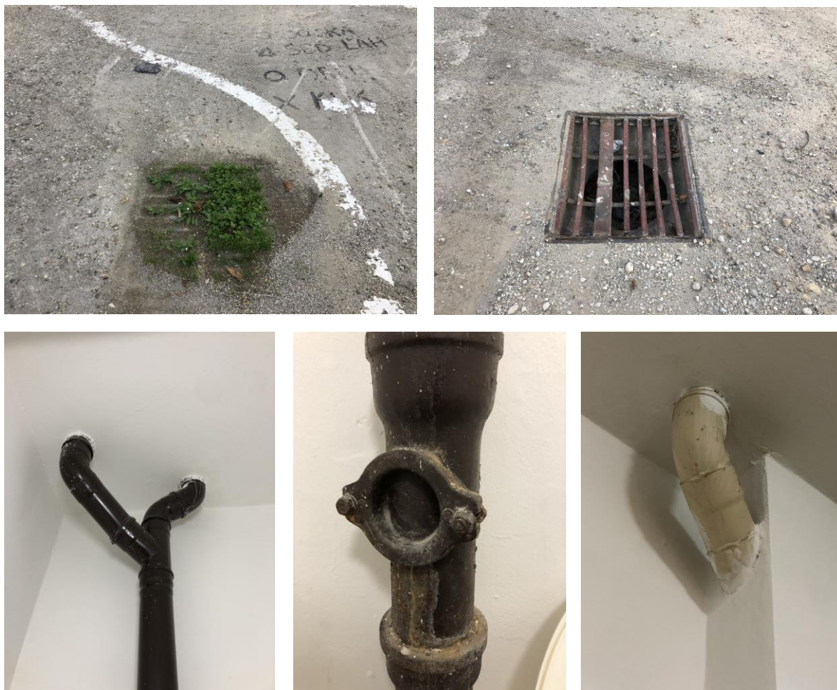
Obr. č. 14 Dažďová kanalizácia v objekt školy
