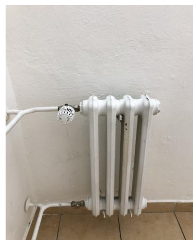
Obr. č. 16 Vykurovacie telesá pôvodné/nové s termostatickými hlaviciami
