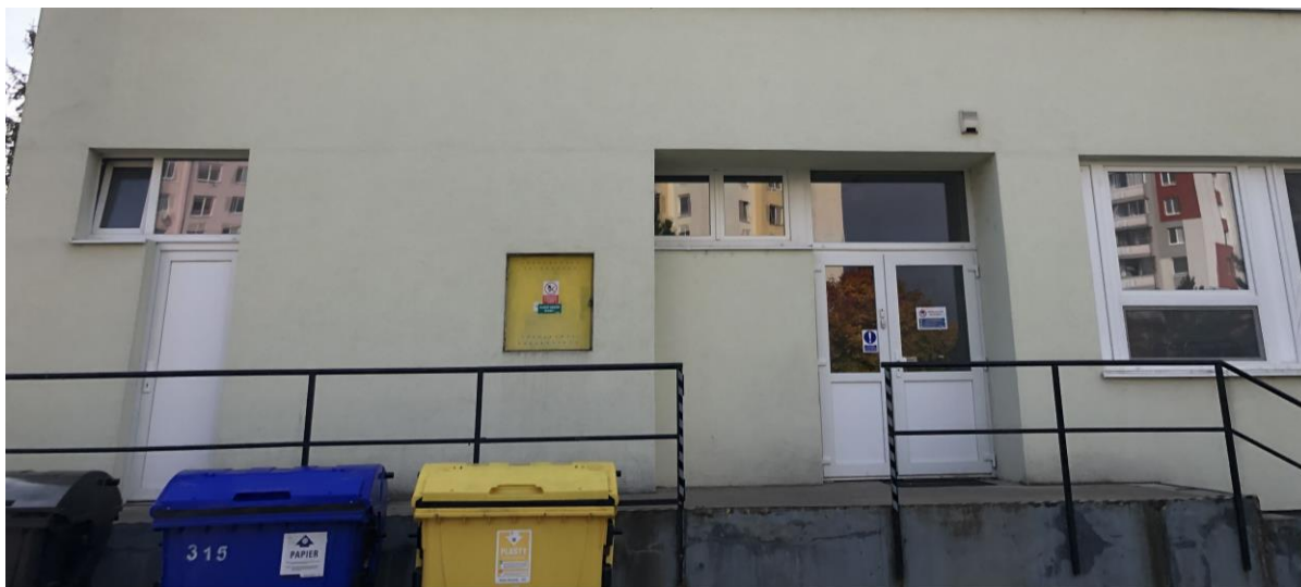
Obr. č. 15 Regulátor a HUP pri vstupe do kuchyne
