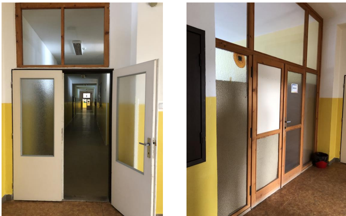
Obr. č. 6 Vnútorne presklenné steny - pôvodné
