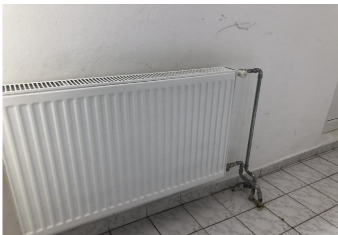
Obr. č. 16 Vykurovacie telesá pôvodné/nové s termostatickými hlaviciami
