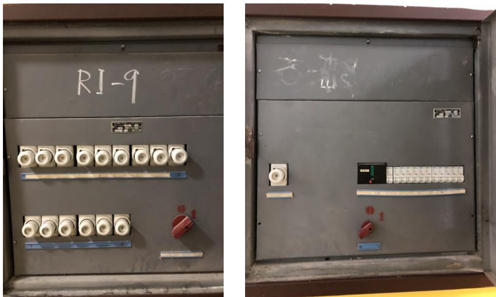
Obr. č. 20 Rozvádzače v interiéri
