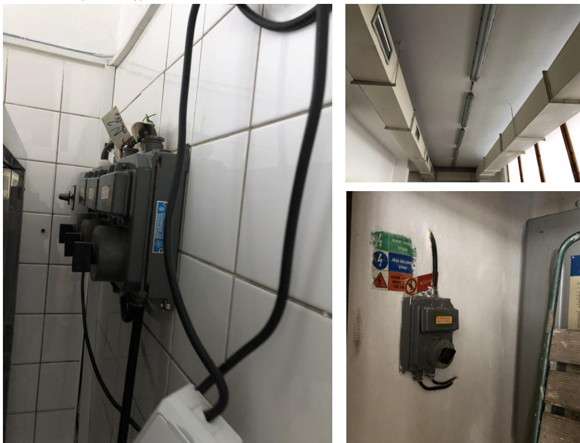
Obr. č. 21 Hlavné vypínače v kuchyni a osvetlenie/rozvody vzduchotechniky
