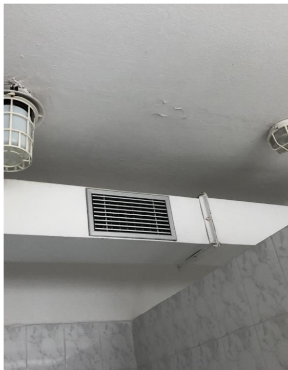
Obr. č. 4 Navlhnuté omietky v umyvárni a WC pri telocvični
