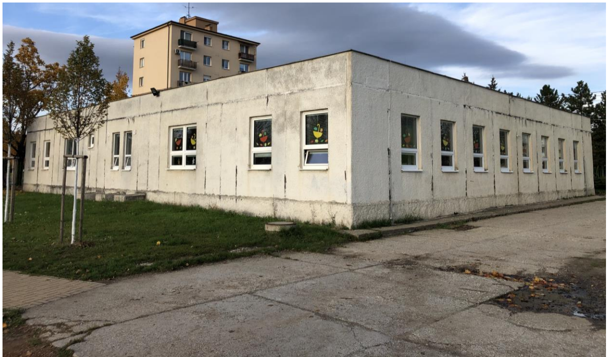
Obr. č. 9 – Poškodené spevnené plochy medzi budovou školy a budovou školského klubu
