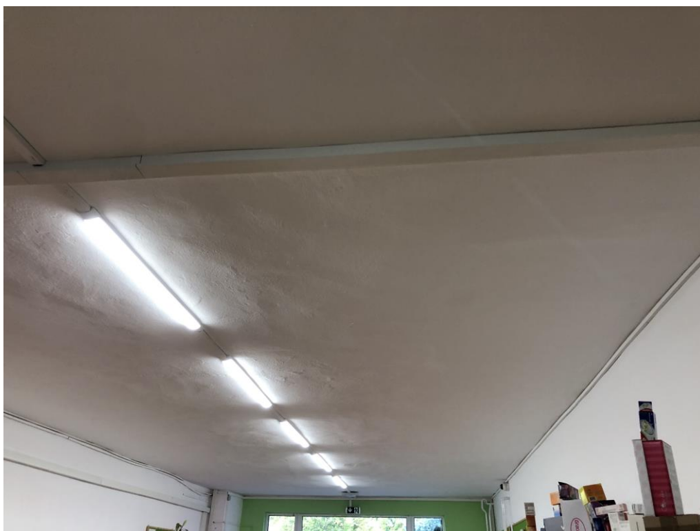
Obr. č. 7 - Stop na chodbe
