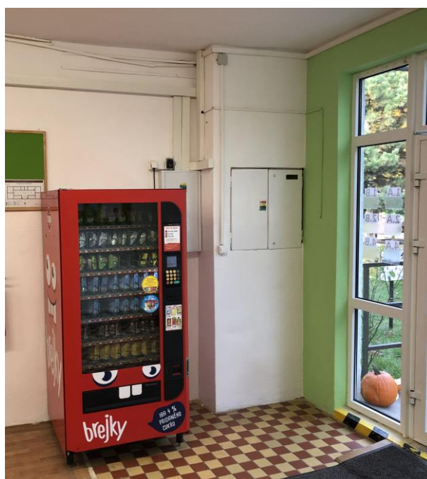
Obr. č.: 14 - Elektrické rozvádzače a ich umiestnenie
