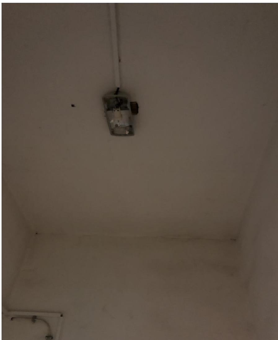
Obr. č. 16 - Pôvodné svietidlo v priestore pre upratovačky
