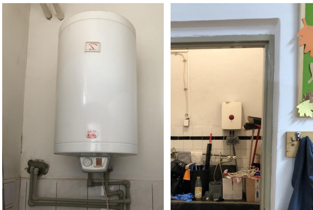
Obr. č. 11 - Elektrický zásobníkový ohrievač vody na teplú vodu a malý elektrický prietokový ohrievač v miestnosti pre upratovačky.
