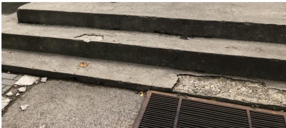
Obr. č. 4 - Schody pri vstupe do objektu
