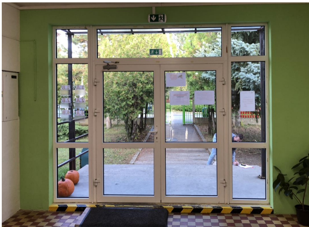
Obr. č. 6 - Vnútročné presklenené steny plastové s izolačným dvojsklom
