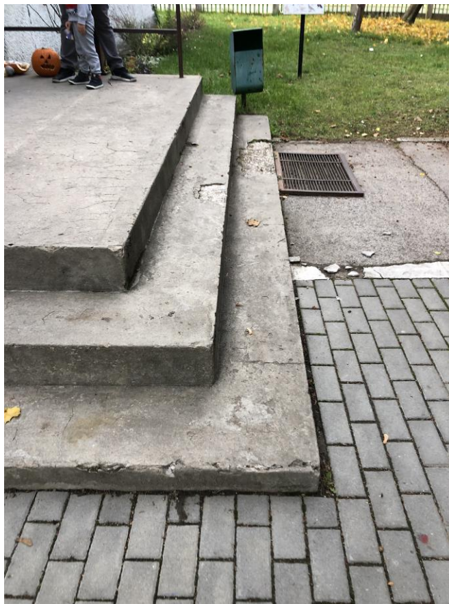
Obr. č. 8 – Spevnené plochy pri vstupe do objektu
