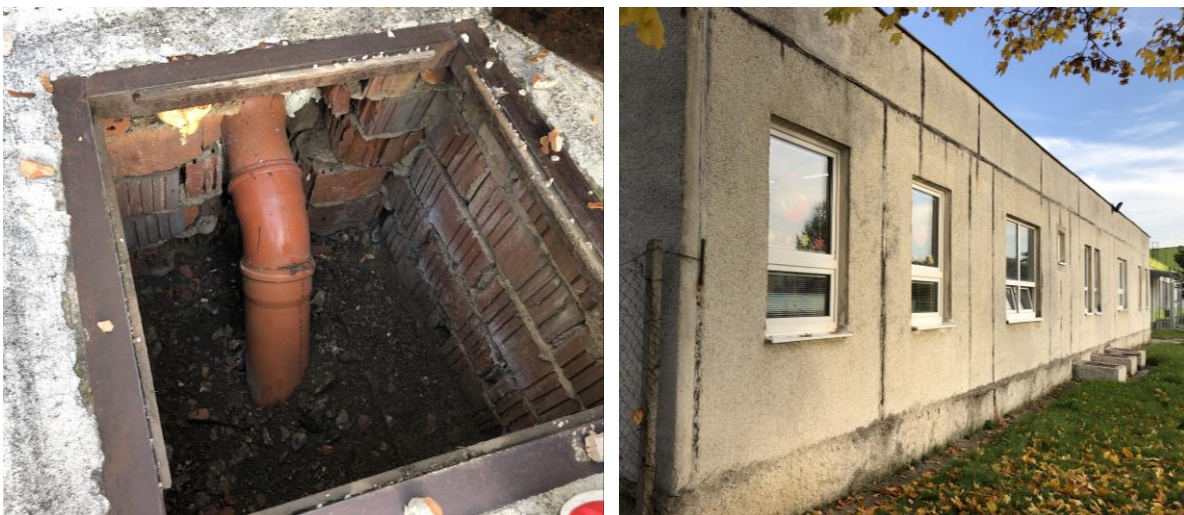
Obr. č. 12 - Kanalizačné potrubie v exteriérovej šachte pri objekte školského klubu
