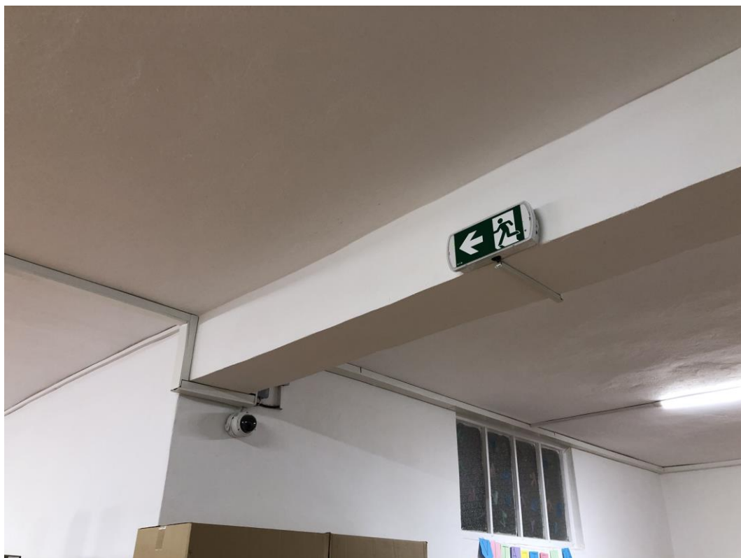
Obr. č.: 17 Kamerový systém, PVC žlab pre slaboprúdové rozvody
