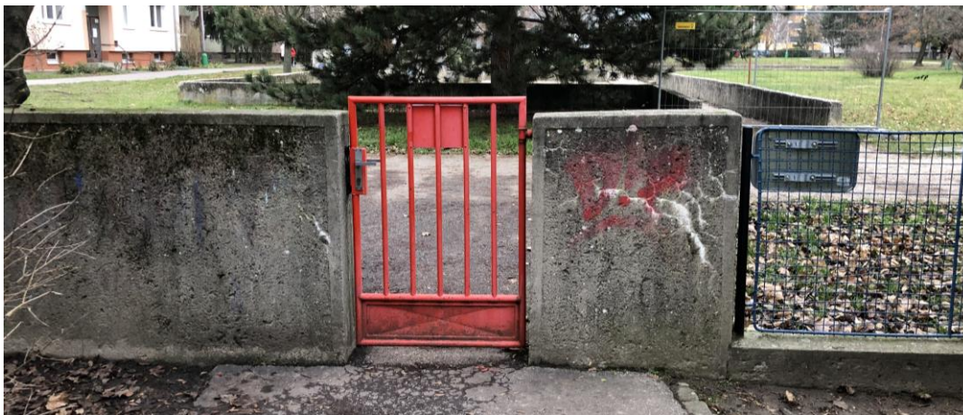
Obr. č. 9 – Oplotenie areálu materskej školy, vstup do areálu
