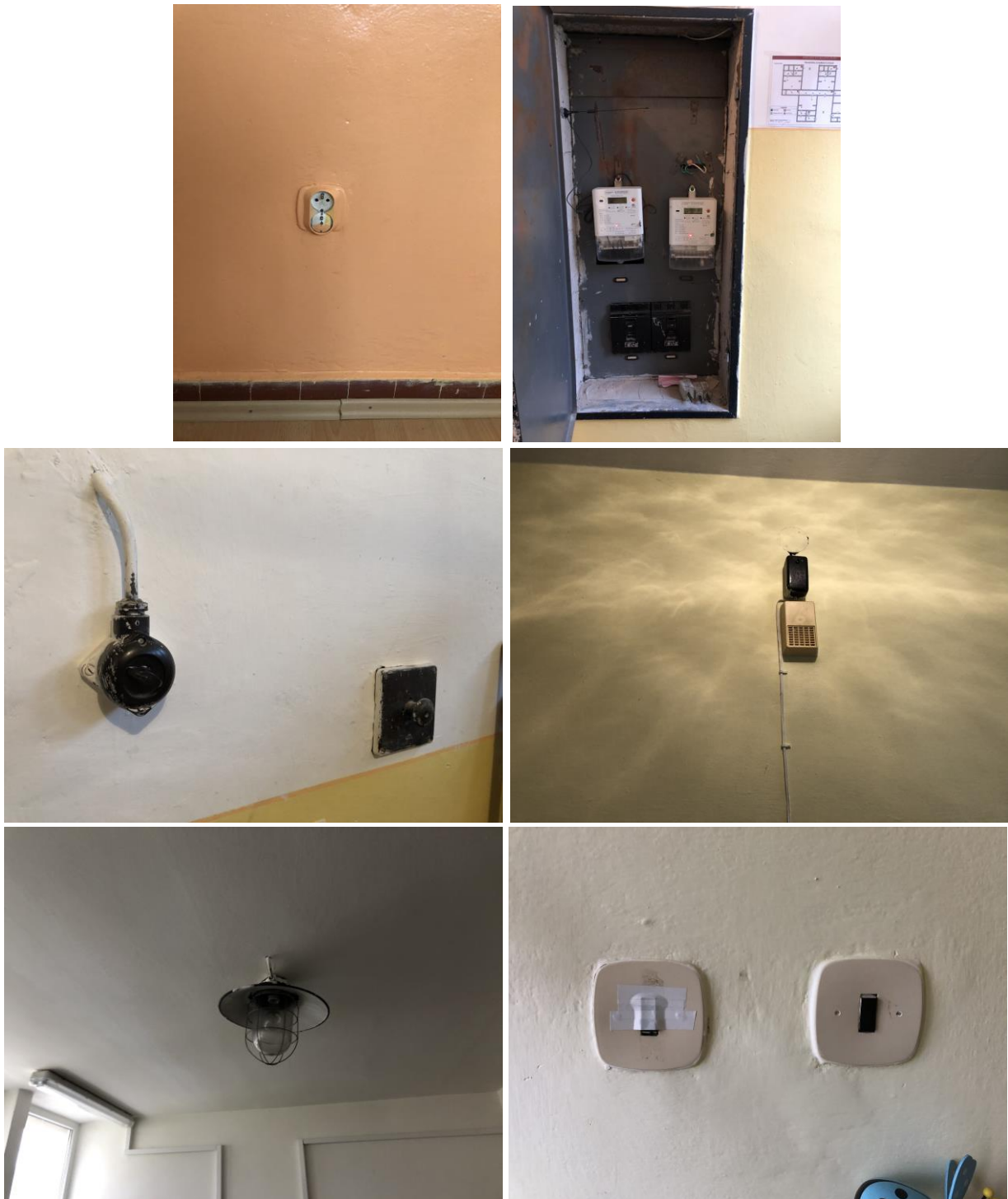
Obr. č. 18 – pôvodné osvetlenie, vypínače, zásuvky.
