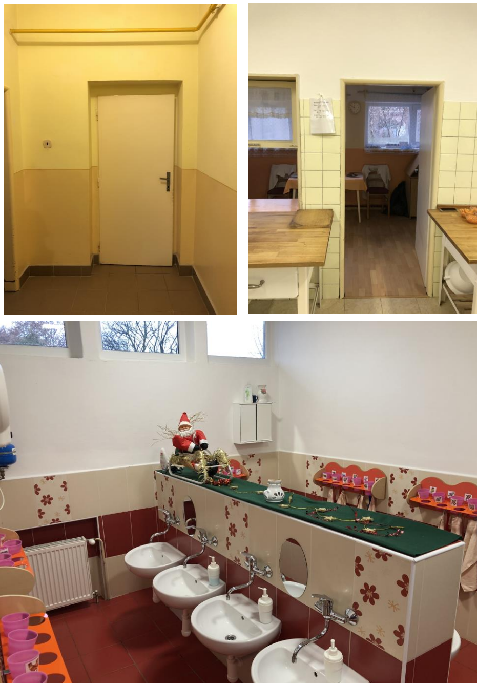
Obr. č. 6 – Úpravy stien interiéru, obklad, olejový ochranný náter
