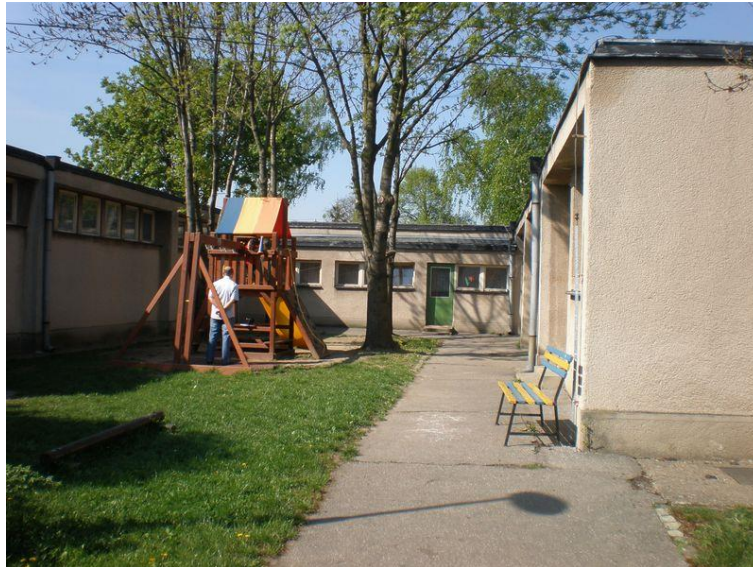
Obr. č. 1 Fotografia priečelia budovy (zdroj: https://www.msahradbami.sk/ )
