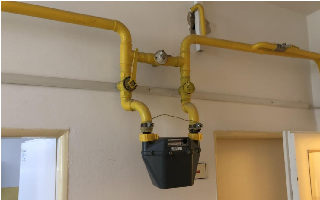
Obr. č. 15 – HUP, meranie spotreby a trasovanie rozvodu plynu
