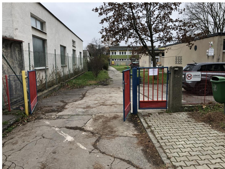
Obr. č. 2 – Vstupy do objektu školy a vstup z ulice Za hradbami
