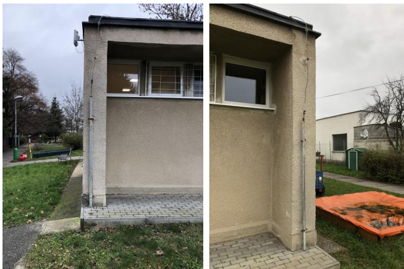
Obr. č. 19 – Bleskozvod
