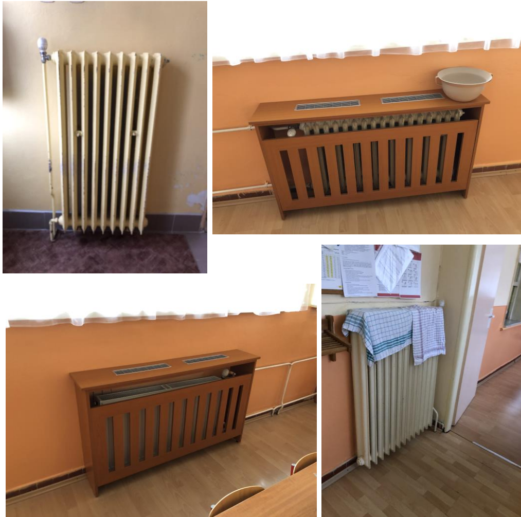
Obr. č. 17 – Vykurovacie telesá a rozvod vykurovania.
