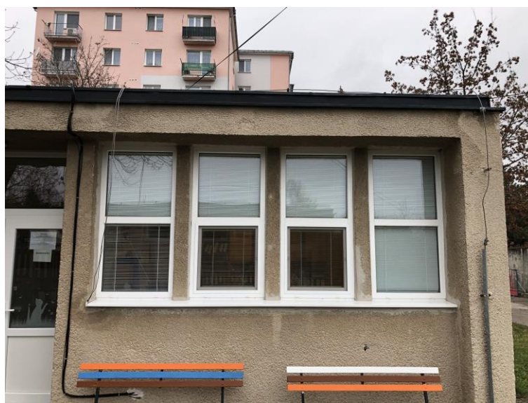
Obr. č. 4 - Vymenené otvorové konštrukcie – plastové okna s izolačným dvojsklom
