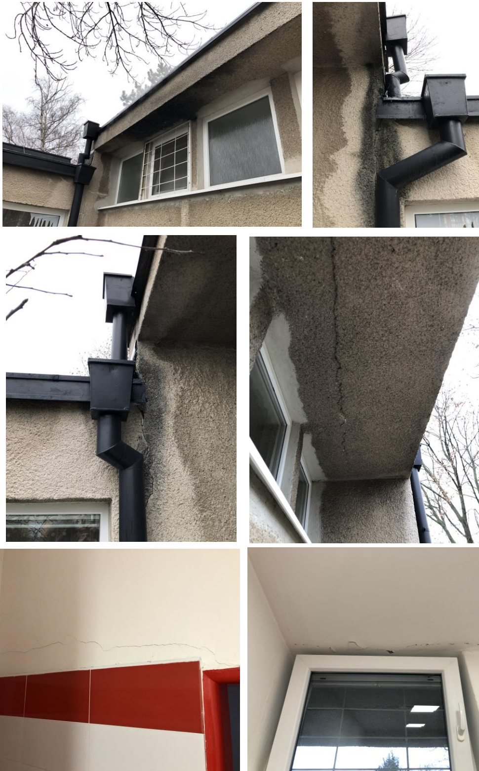
Obr. č. 3 – Pohľad na fasádu objektu, systémové vody fasády exteriér a interiér
