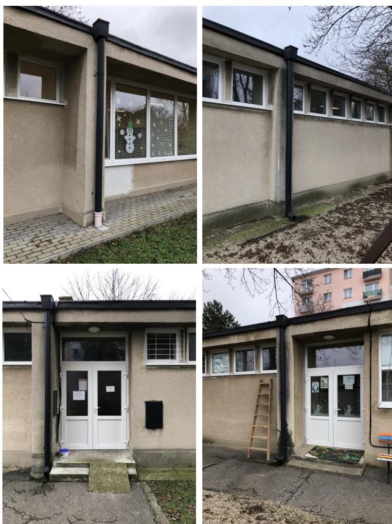
Obr. č. 14 – Dažďové zvody odvedené voľne na terén/do dažďovej kanalizácie
