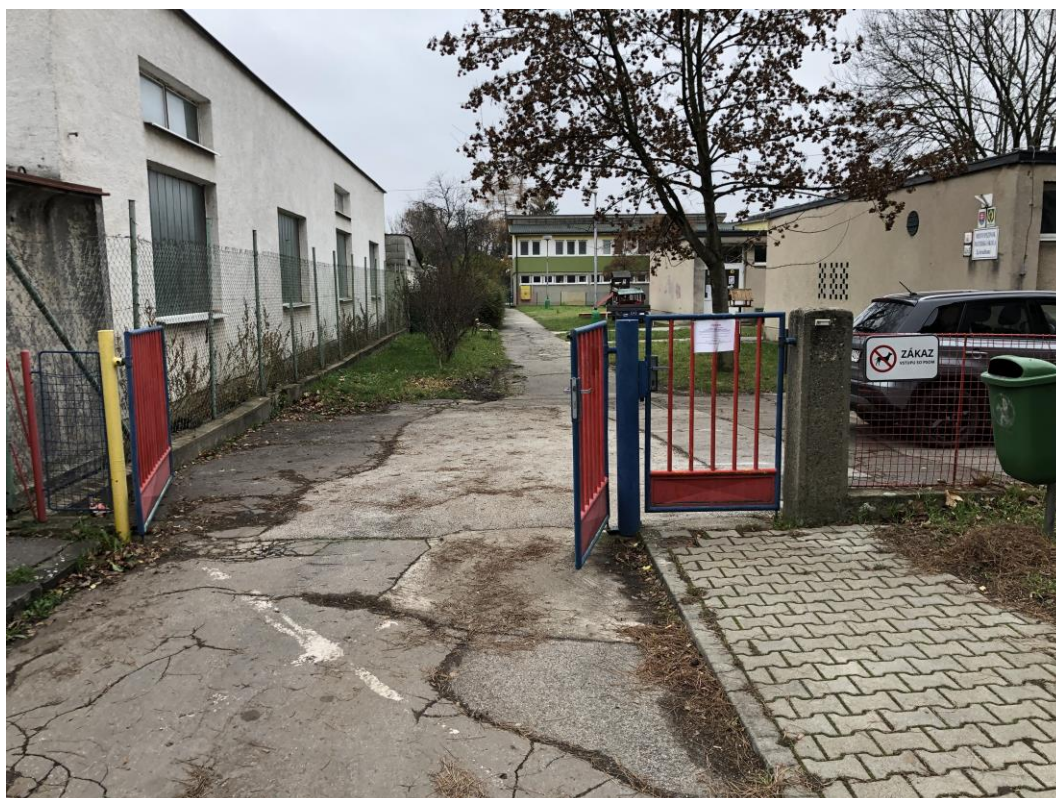
Obr. č. 11 – Vstupy do areálu – z ulice Za hradbami
