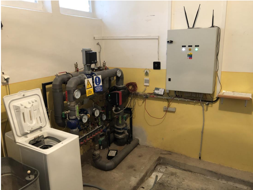
Obr. č. 16 – Technická miestnosť - prívod teplej vody na vykurovanie z výmenníkovej stanice
