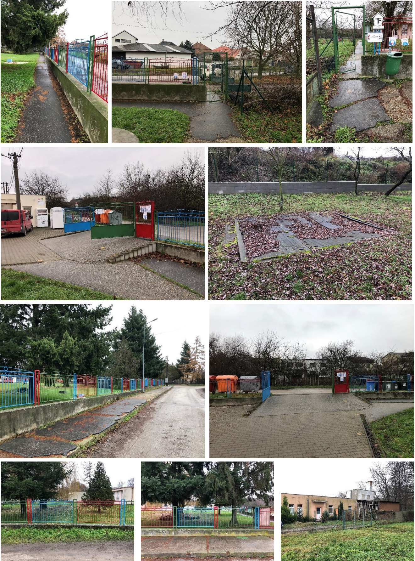
Obr. č. 10 – Oplotenie areálu materskej školy
