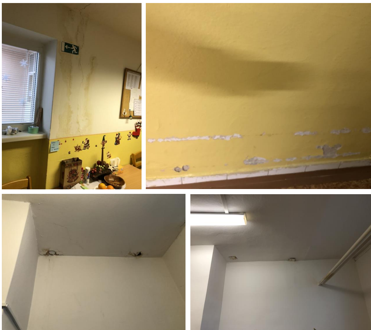
Obr. č. 4 – Trhliny, navlhnuté miesta z dažďových zvodov a zo spodnej stavby
