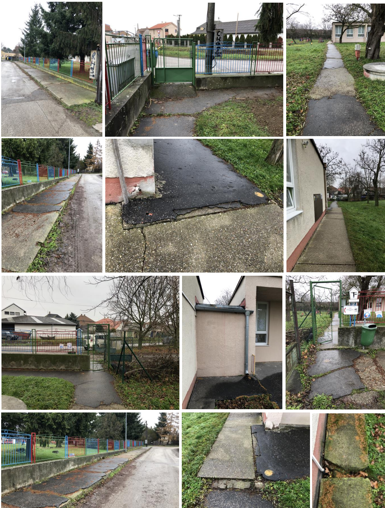
Obr. č. 9 – Spevnené plochy v okolí objektu materskej školy
