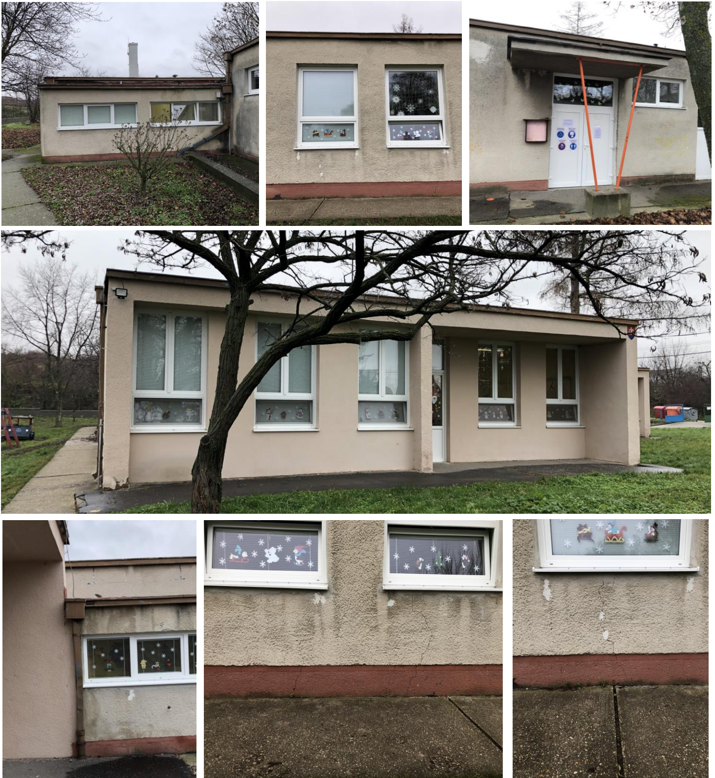
Obr. č. 3 – Pohľady na fasádu objektu, trhliny, zatekanie od dažďových zvodov
