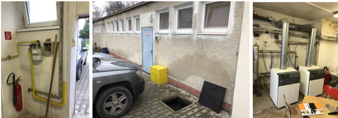
Obr. č. 16 – HUP a trasovanie rozvodu plynu, kotolňa
