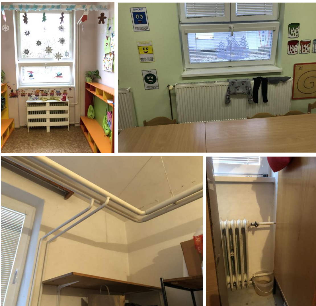
Obr. č. 17 – Vykurovacie telesá, rozvod vykurovania, kotolňa.
