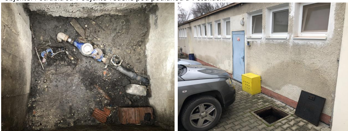
Obr. č. 14 – Umiestnenie vodomernej šachty, vodomer
