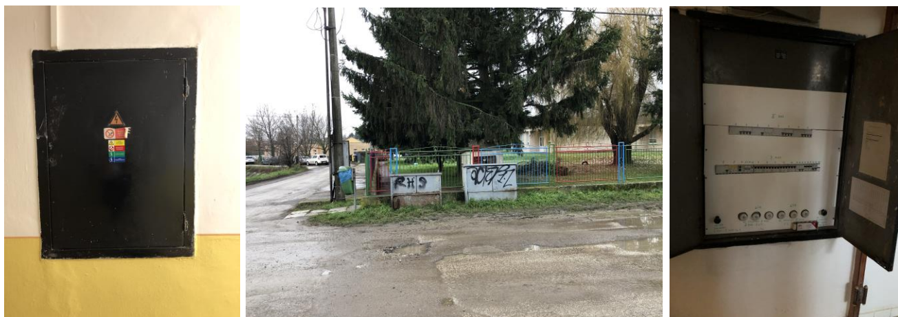
Obr. č. 18 – Rozvádzače
