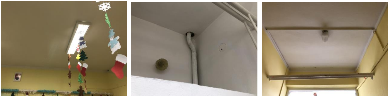
Obr. č. 19 – osvetlenie v herni, WC, núdzové osvetlenie (bez piktogramu)
