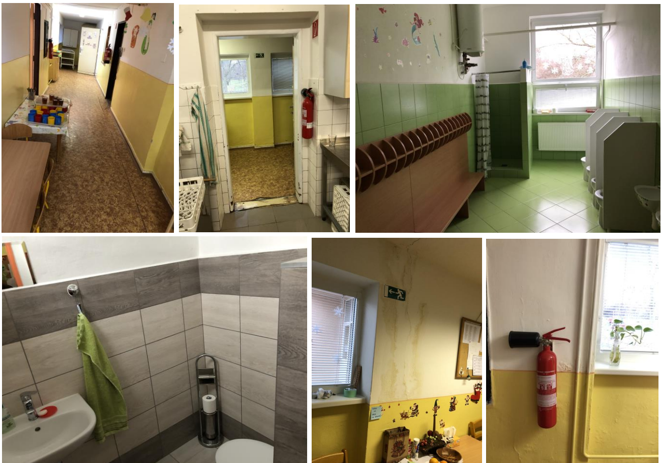
Obr. č. 7 – Úpravy stien interiéru
