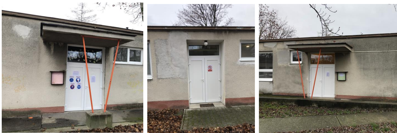
Obr. č. 2 – Bezbariérový vstup do objektu školy
