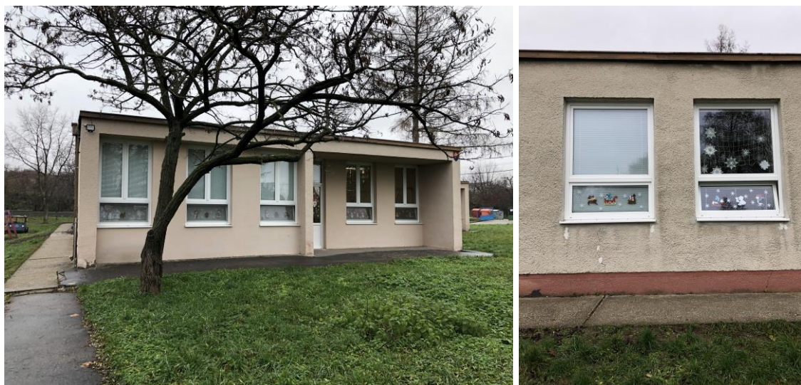
Obr. č. 5 - Vymenené otvorové konštrukcie – plastové okna s izolačným dvojsklom, dvere
