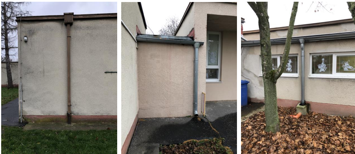
Obr. č. 15 – Dažďové zvody odvedené voľne na terén/do dažďovej kanalizácie
