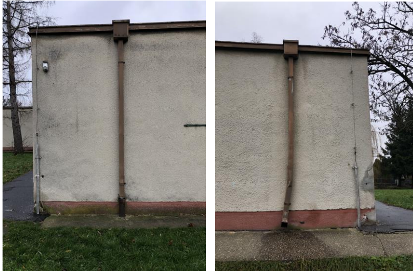
Obr. č. 20 – Bleskozvod
