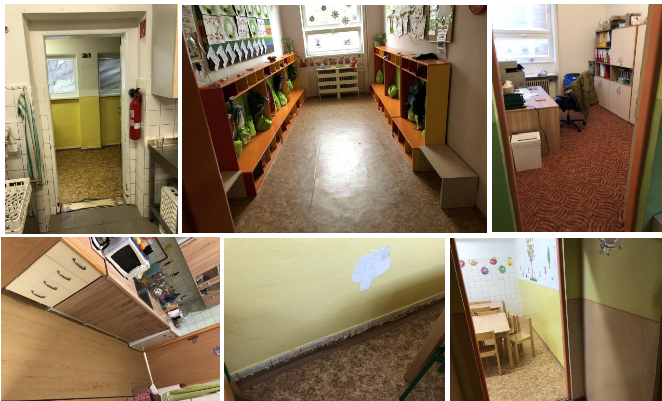
Obr. č. 8 – Podlahy v objekte
