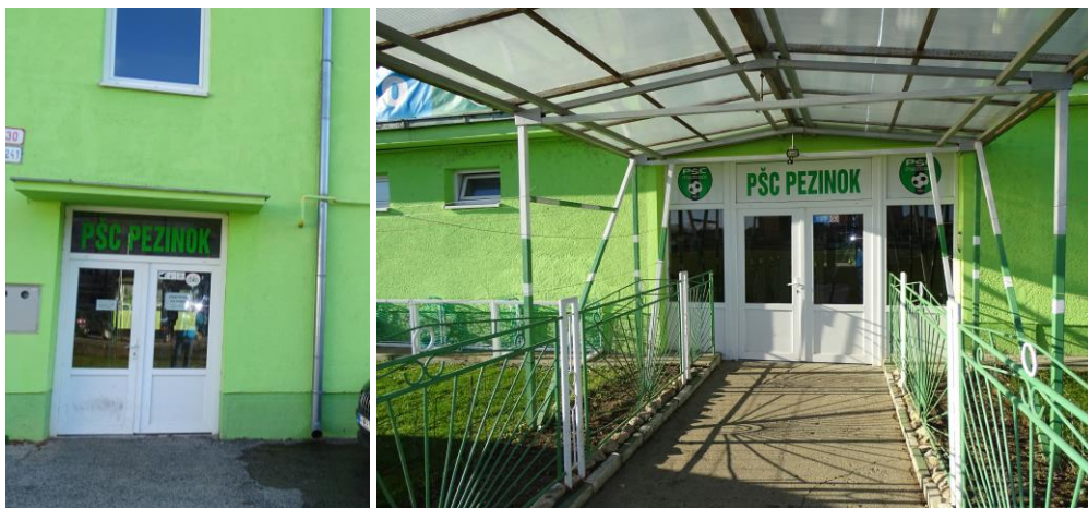
Obr. č. 2 Vstup do budovy, východ na hraciu plochu
