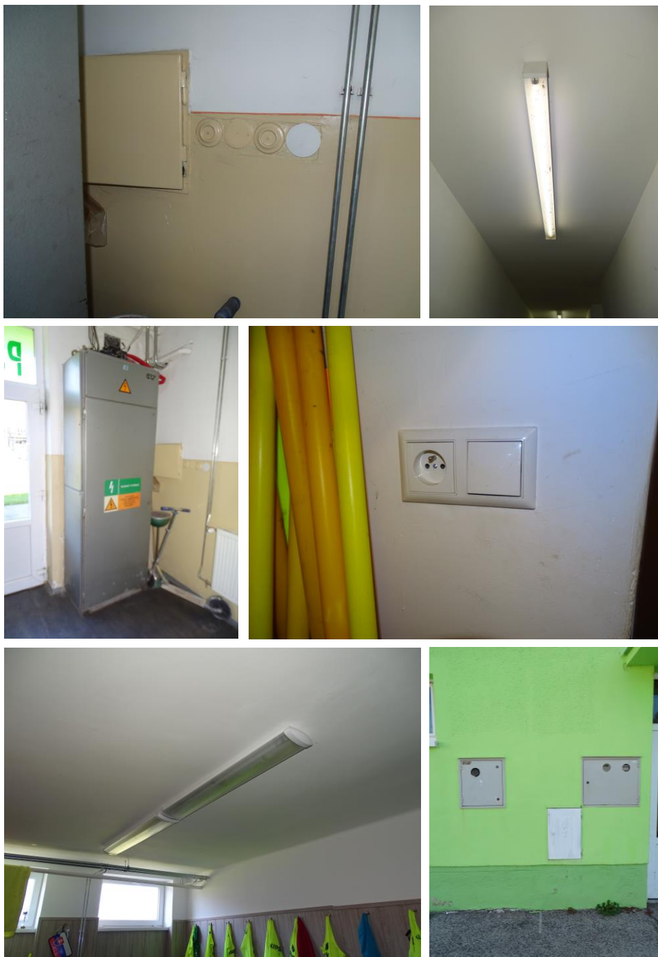
Obr. č. 17 – Pôvodné vypínače, nové svietidlá, rozvodáč, nové vypínače – zásuvky, nové svietidlá, meranie spotreby el. energie pri vstupe do budovy.
