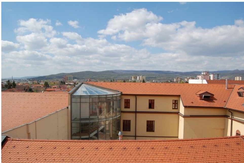
11. Vnútorný pohľad č. 8 smerom na západ na objekt Krušičovej kúrie. Foto: MH, 23. 4. 2021
